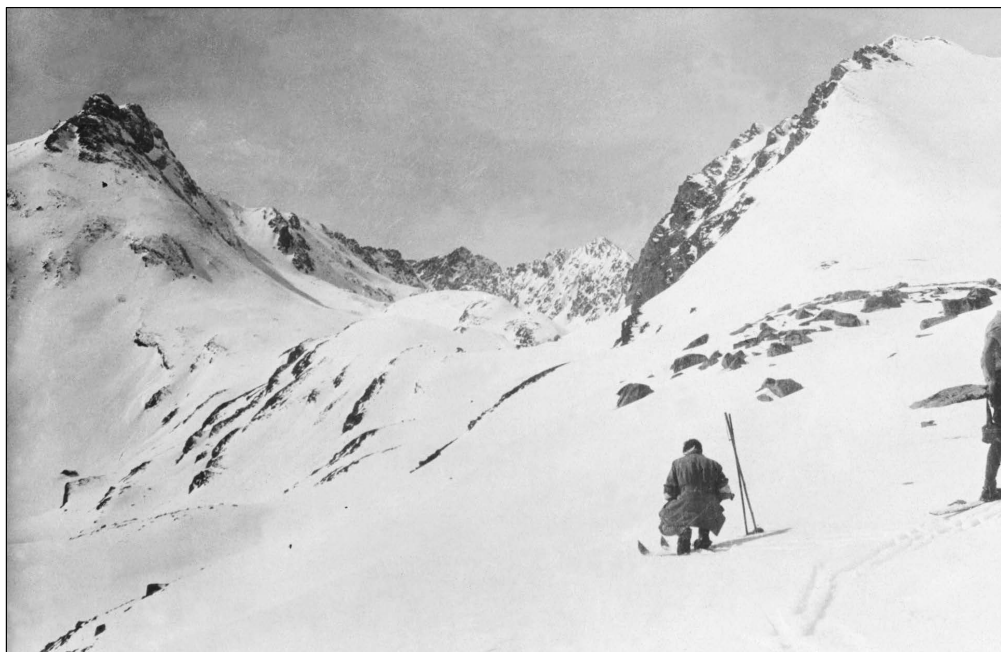
Fig. 9: Descans tecnic. 1919. Cliché Estasen. Archiu CEC
