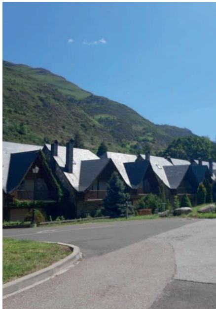
Fig. 39. Accès dera urbanizacion.
