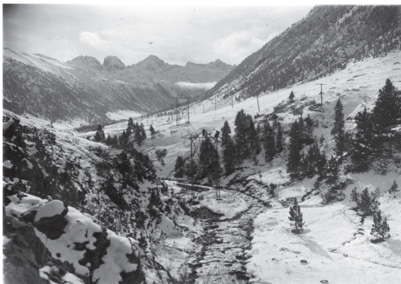
FIGURA 11. Estenuda electrica de 110 kV que travessaue pera Garona de Ruda, e anaue enquiara Pobla de Segur (Palhars Jussà). AUTORIA: desconeshuda. HONS: Fons Iazard-Forrellad.
