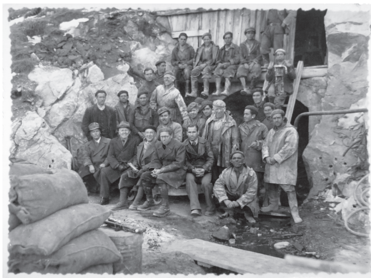
FIGURA 9. Trebalhadors en cale der estanh Tòrt de Rius. AUTORIA: Pere Piqué. Hons: Musèu Idroelectric de Capdelha. Entre 1950 e 1955.
