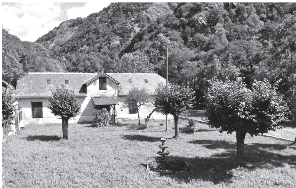
Actuaument eth polit edifici deth " Casino du Pont du Roy " demore abandonat ath cant dera Garona, mès ei eth millhor conservat des vielhes sales de jòc (Fot. Joan-Ramon González).
