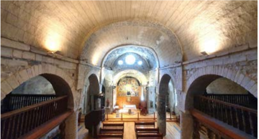
Figura 48. Vòutes damb granes deformacions ena vòuta dera nau centrau de Santa Maria d'Arties [34]
