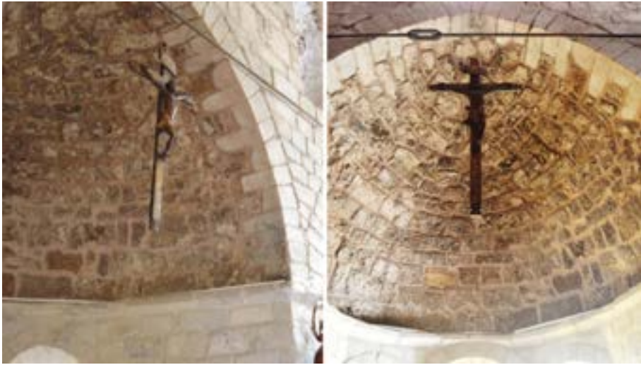
Figura 194. Tensor sus eth presbitèri de Sant Estève de Betren [29] coma supòrt deth santcrist
