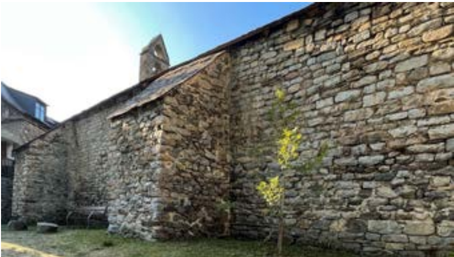
Figura 158. Contrahòrts de reparacion estructurala dera façada septentrionala de Santa Eulària d'Unha [38] que configuren era sua imatge
