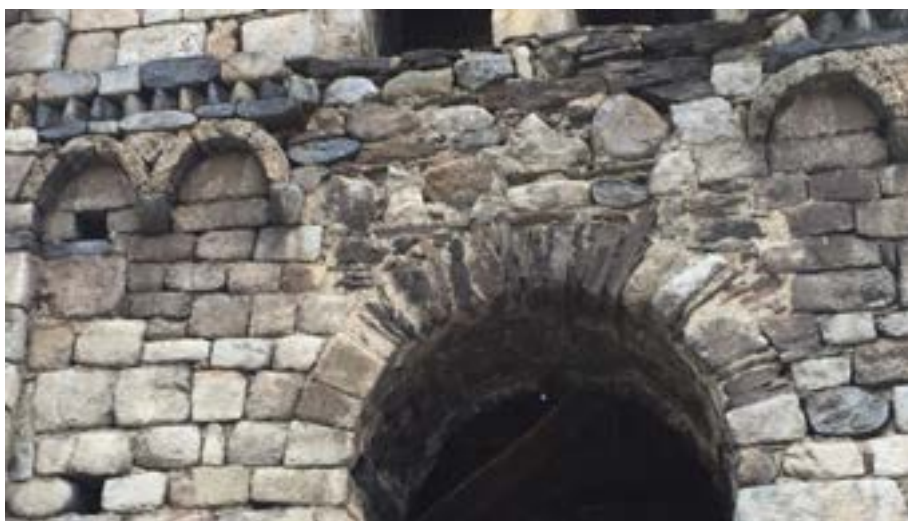
Figura 185. Detalh dera continuïtat des arcs cècs deth campanau d'Era Mair de Diu dera Purificacion de Bossòst [6]
