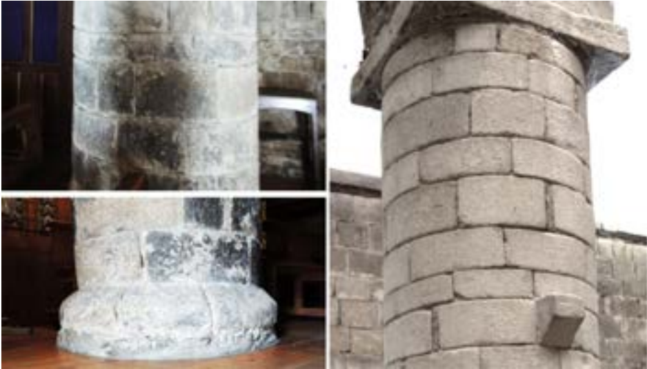
Figura 53. Detalls de pilars non monolitics d'Era Mair de Diu dera Purificacion de Bossòst [6]
