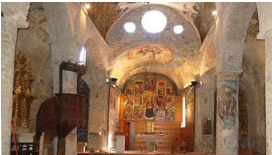
Figura 87. Pilars de seccion circulara de Santa Maria d'Arties [34]
