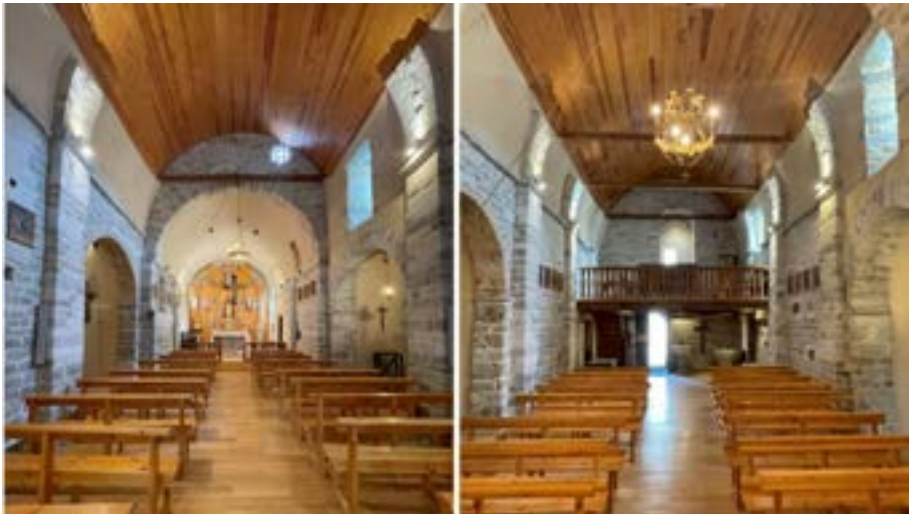
Figura 174. Nau de Sant Fèlix de Bagergue [40] a on s'obsèrve era diferéncia ena vòuta de canon
