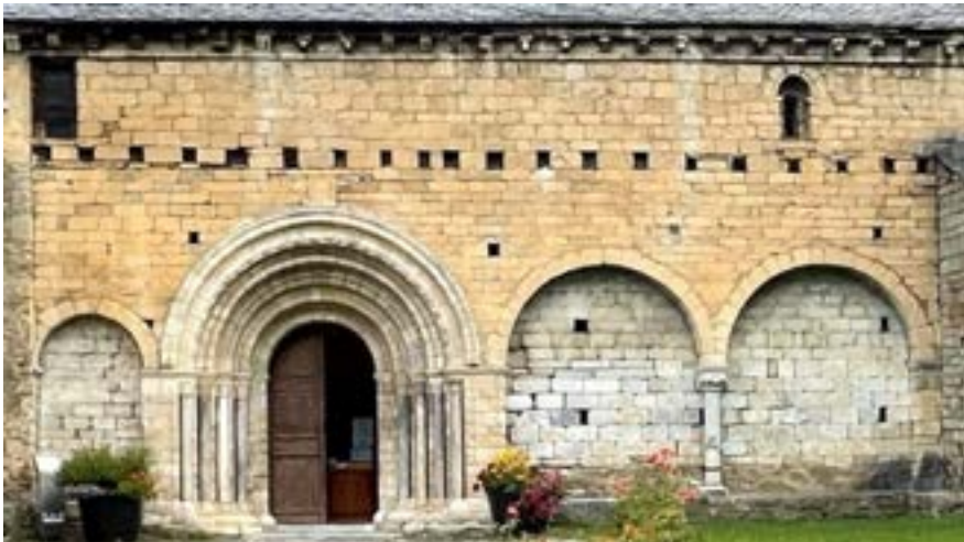
Figura 145. Parament meridionau de Sant Andreu de Salardú [37] bastit inicialment sense elements de resistència
