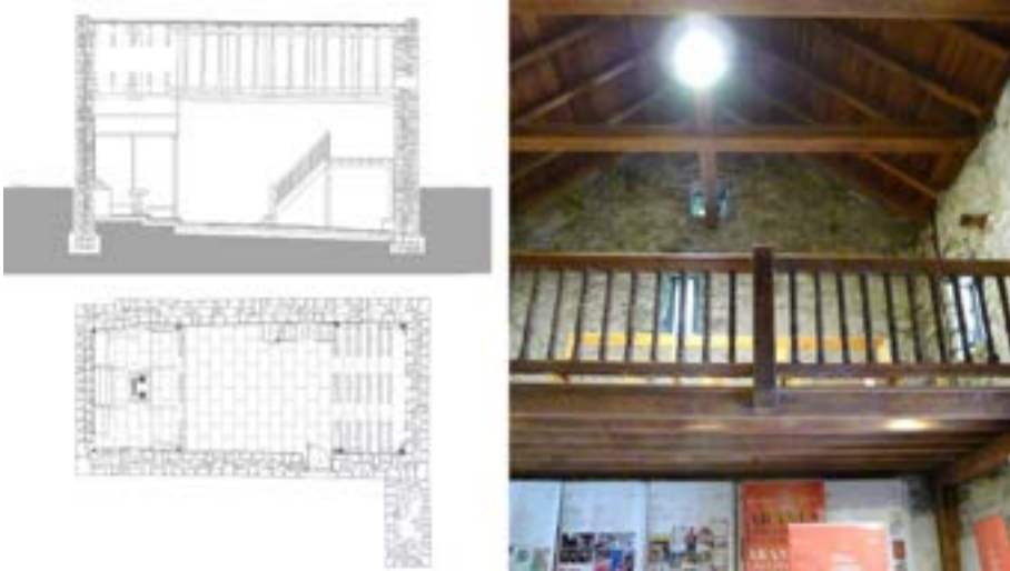
Figura 127. Detalh dera seccion deth còr de Sant Estèue de Tredòs [39] dispusat sus pilars de husta
