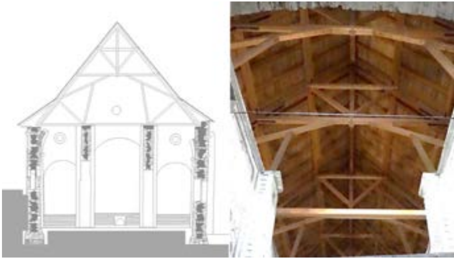
Figura 77. Reconstrucció de cubèrtes d'après deth col·lapse des vòutes de Santa Maria de Cap d'Aran de Tredòs [41]
