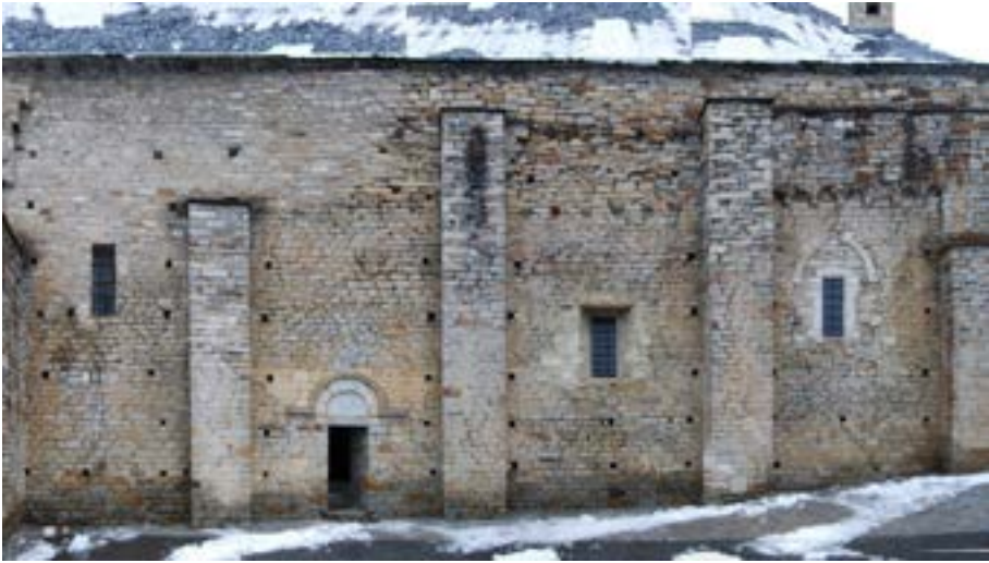
Figura 149. Contrahòrts dera façada meridionau de Santa Maria de Cap d'Aran de Tredòs [41]
