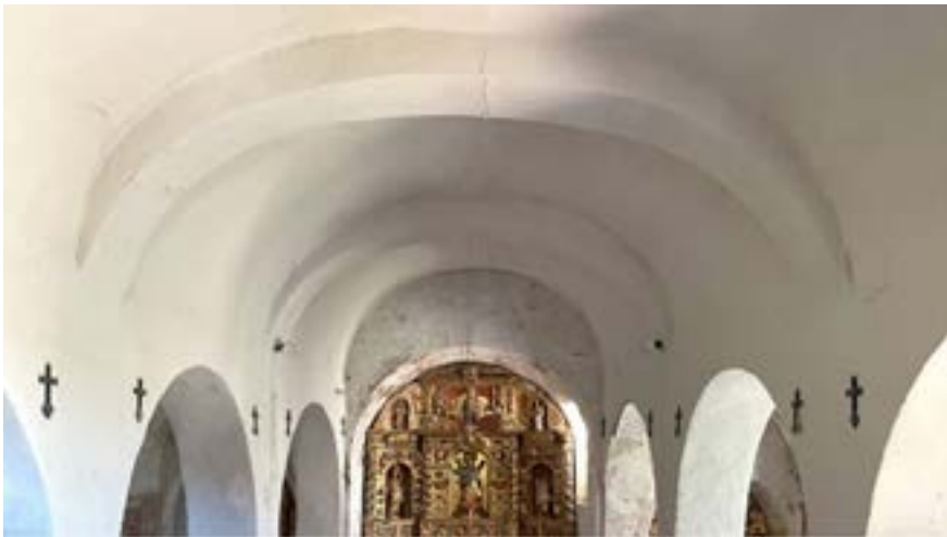
Figura 116. Generatritzes de vòutes rebaishades ena nau centrau dera planta basilicau de Santa Eulària d'Unha [38]
