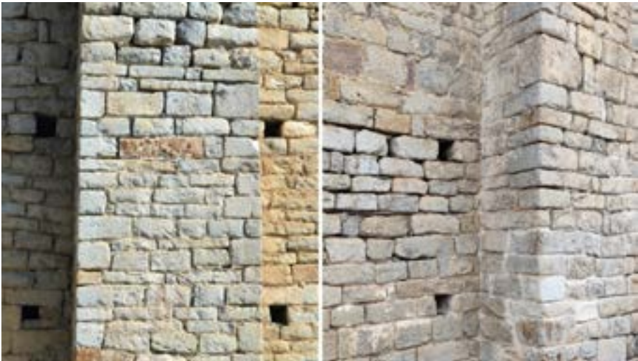
Figura 496. Detalh der aparelh des contrahòrts dera façada meridionau de Santa Maria de Cap d'Aran de Tredòs [41] damb era traua de mur e contrahòrt
