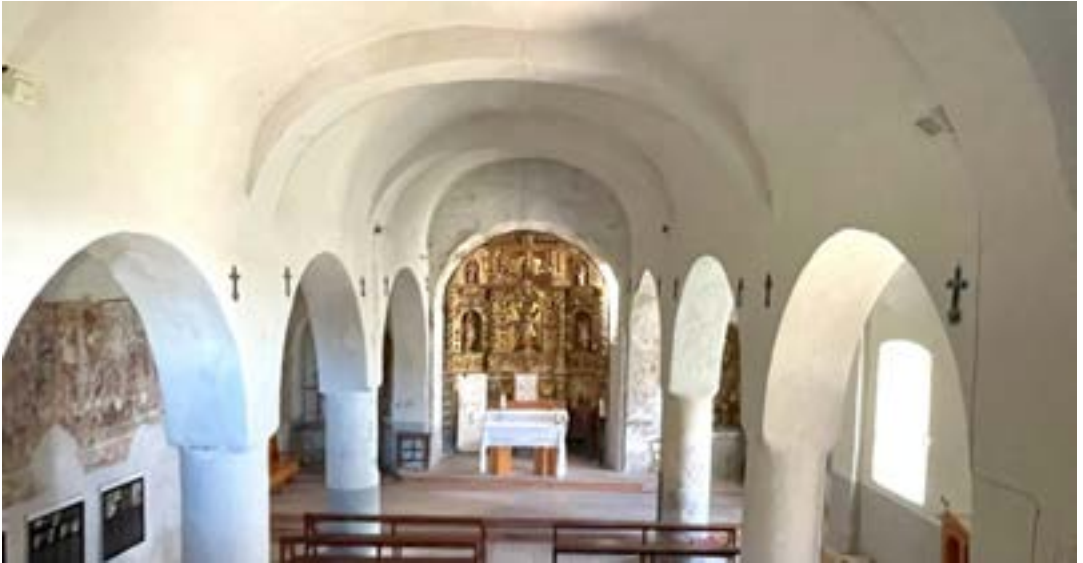
Figura 100. Geometria funiculara des vòutes de Santa Eulària d'Unha [38]
