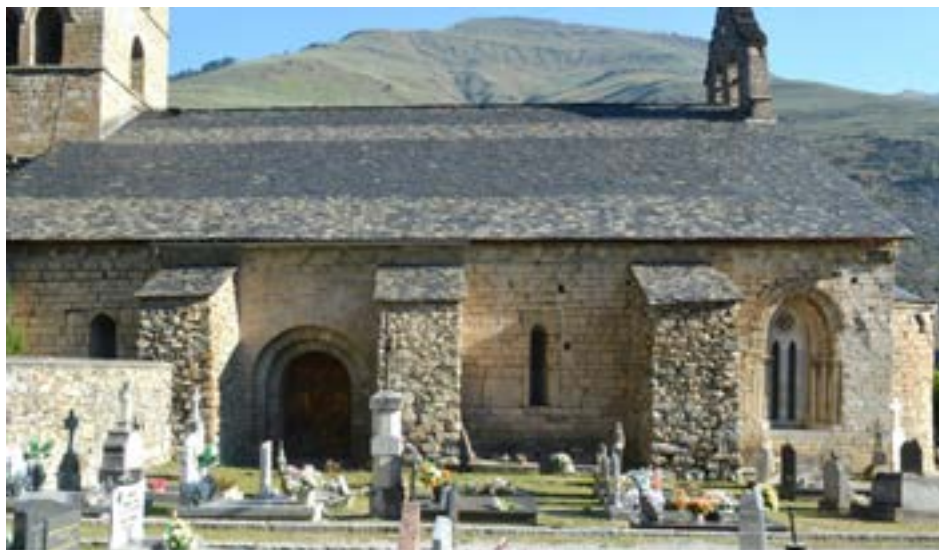
Figura 155. Contrahòrts fòrta dera façada meridionau de Santa Maria d'Arties [34] que configure era sua façada
