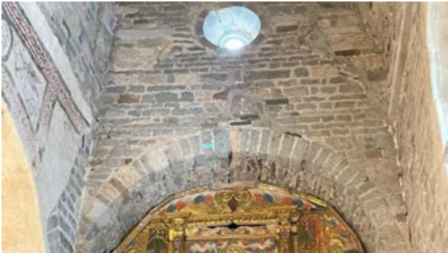
Figura 163. Traça de miei punt ena cabeçada de Santa Maria de Cap d'Aran de Tredòs [41]
