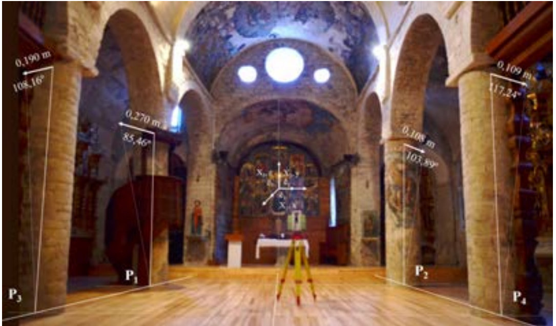
Figura 95. Plans de regresson dera deformacion des pilars de Santa Maria d'Arties [34]
