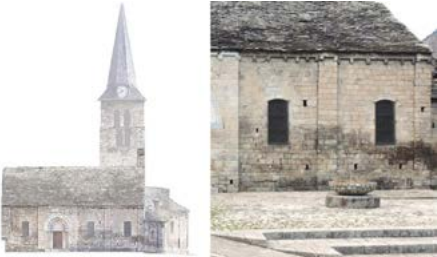
Figura 147. Contrahòrts dera façada meridionau d'Era Mair de Diu dera Purificacion de Bossòst [6]
