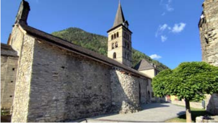
Figura 153. Contrahòrts dera façada septentrionau de Santa Maria d'Arties [34] que configuren era sua naua imatge
