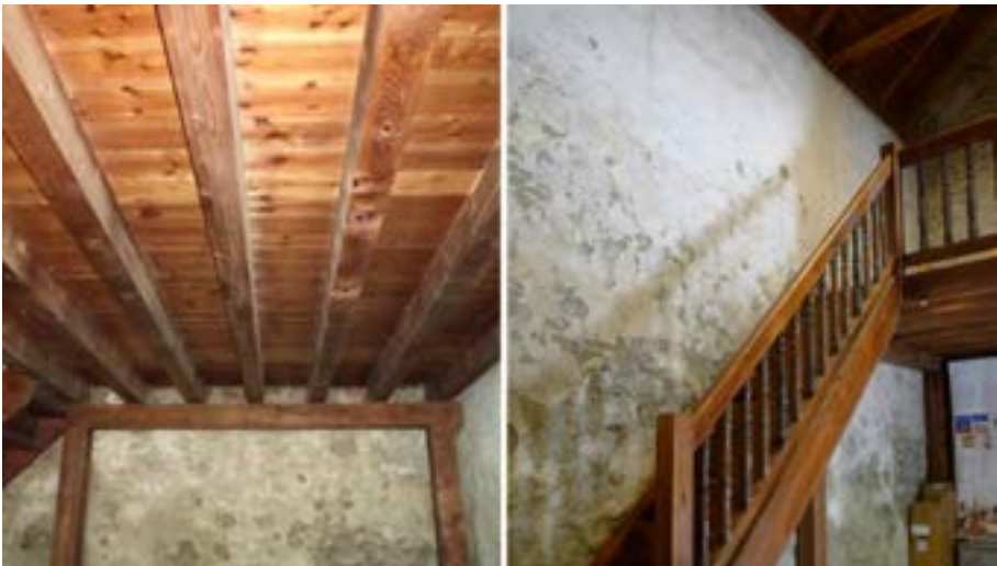
Figura 605. Detalh dera estructura inferiora deth còr de Sant Estèue de Tredòs [39], apuada sus en portic de husta.
