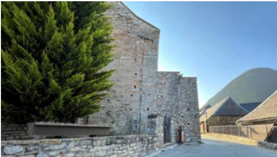
Figura 160. Contrahòrt de reparacion estructurai dea façada meridionau de Santa Maria de Cap d'Aran de Tredòs [41] ena sua trobada damb era occidentau
