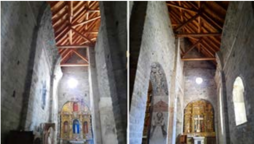
Figura 168. Linha de trincament dera antica vòuta de quart de canon ena nautada des traucs enes naus centraus de Santa Maria de Cap d'Aran de Tredòs [41]
