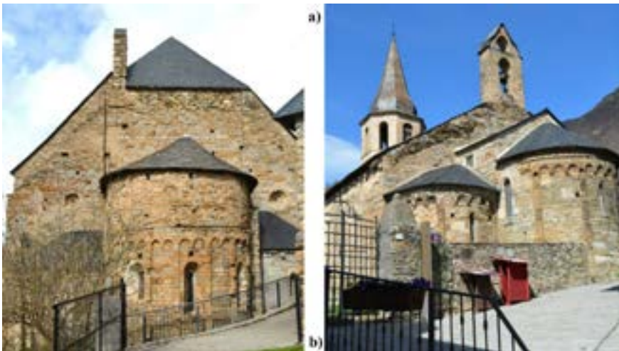
Figura 124. a) Absida de Santa Maria de Cap d'Aran de Tredòs [41]; b) Absida de Santa Eulària d'Unha [38]
