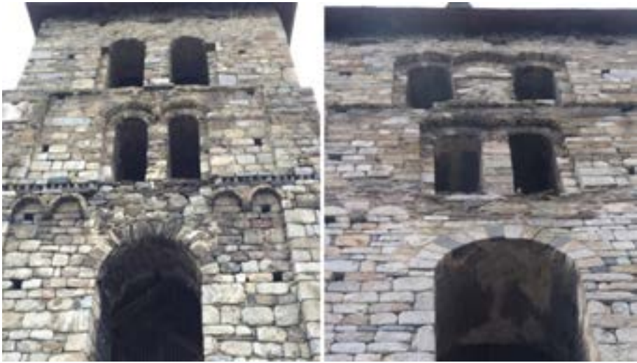
Figura 181. Discontinuitat des arcs cècs deth campanau d'Era Mair de Diu dera Purificacion de Bossòst [6]
