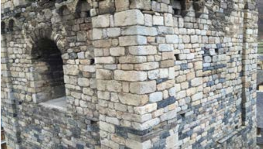
Figura 183. Barratge deth primèr nivèu deth campanau d'Era Mair de Diu dera Purificacion de Bossòst [6]
