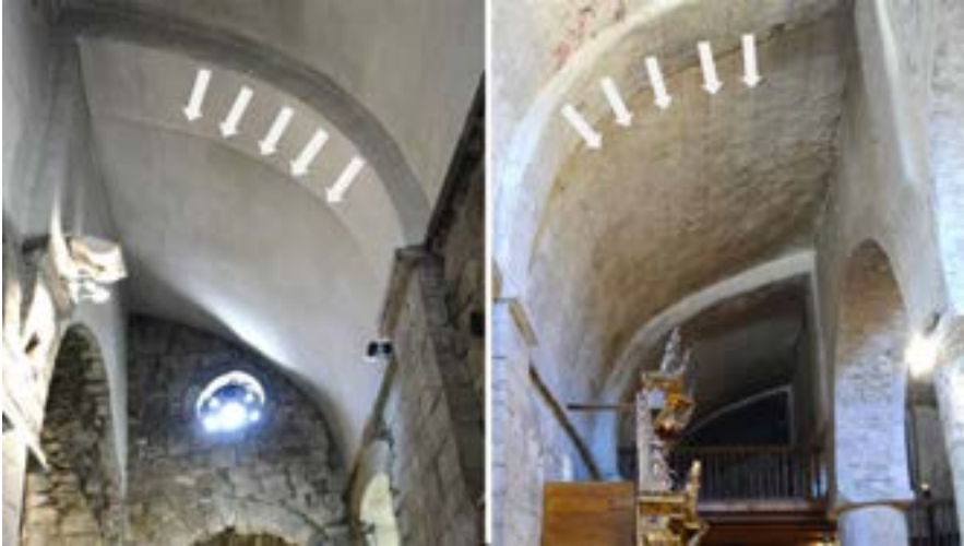
Figura 40. Vòutes funiculars en Era Mair de Diu dera Purificacion de Bossòst [6]
