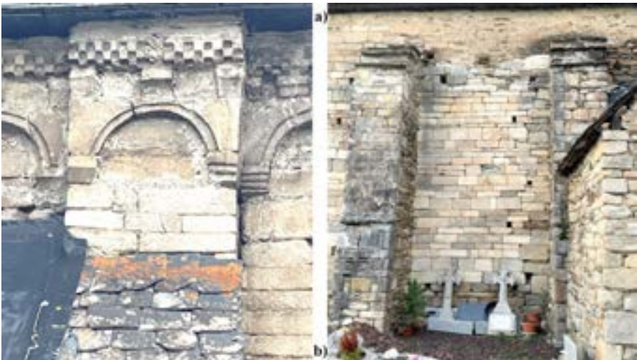
Figura 418. Diferéncia d'acabat enes murs deth serptentrion e deth meddia de Sant Fèlix de Bagergue [40]
