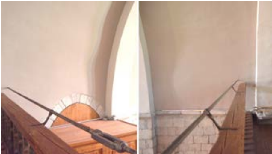
Figura 195. Tensor en còr de Sant Estève de Betren [29] en tot préner coma supòrt era barana deth balcon lheuut
