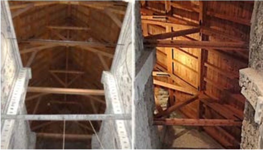
Figura 167. Impòsta dera antica vòuta de canon de Santa Maria de Cap d'Aran de Tredòs [41]
