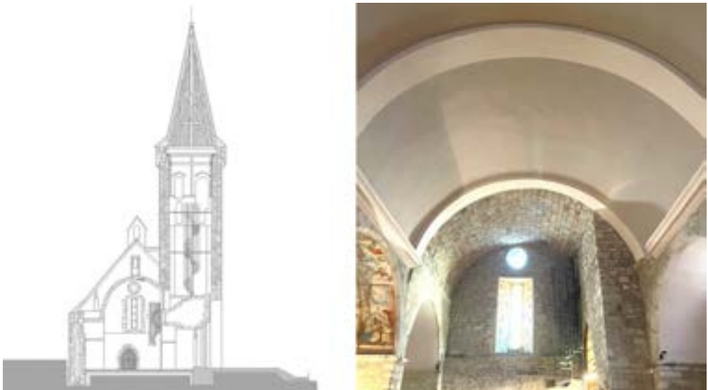
Figura 74. Vòutes de canon de generatrix semicirculara de Sant Miquèu de Vielha [28]
