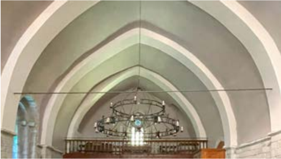
Figura 192. Tensors ena vòuta de canon apuntada de Sant Estève de Betren [29]
