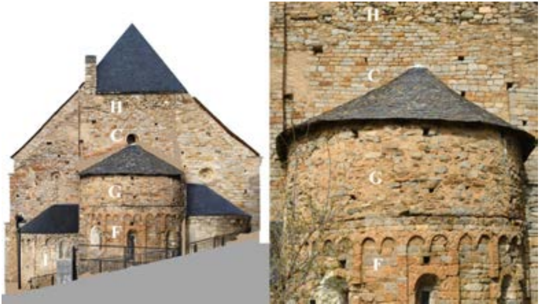
Figura 104. Tipologia d'aparelh ena absida de Santa Maria de Cap d'Aran de Tredòs [41]
