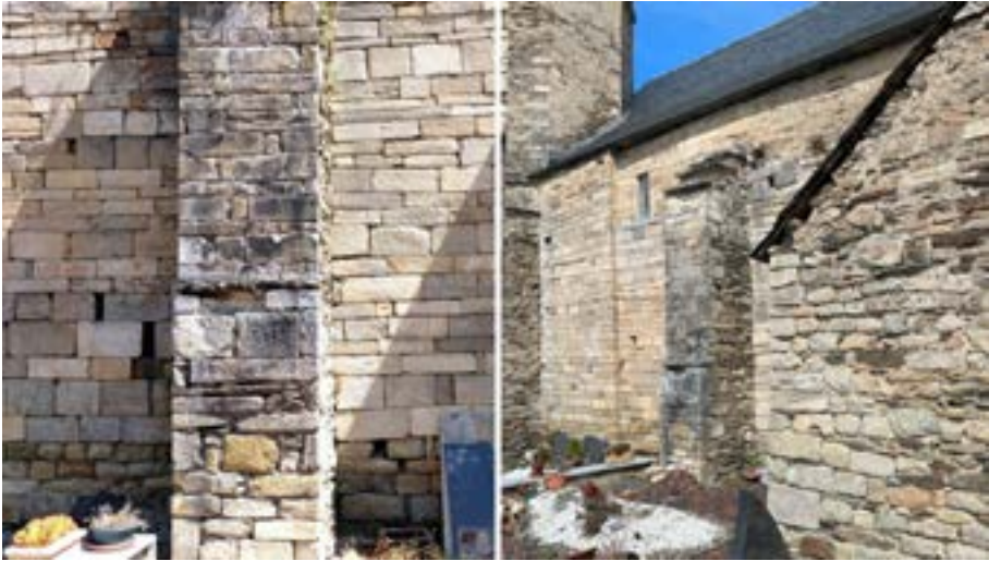
Figura 179. Contrahòrts deth mur meridionau de Sant Fèlix de Bagargue [40]
