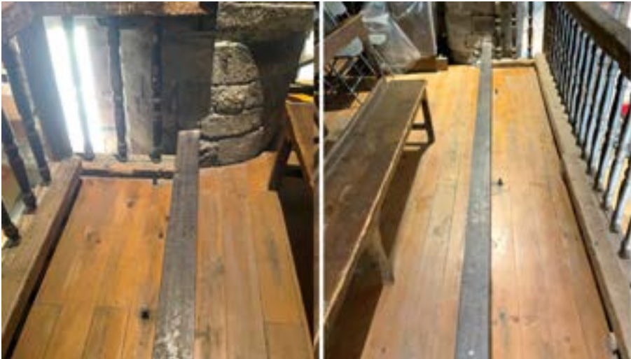
Figura 197. Viga de acèr en còr d'Era Mair de Diu dera Purificacion de Bossòst [6]
