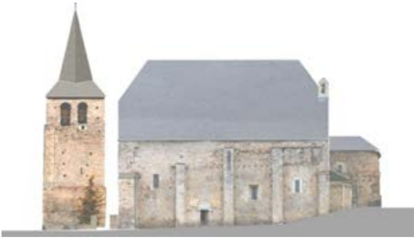
Figura 161. Fotogrametria dera façada de meddia de Santa Maria de Cap d'Aran de Tredòs [41] damb dus nivèus en sòn acabat
