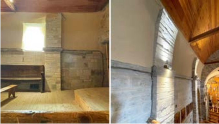
Figura 417. Linhas de collapse d'arcs e vòutes sus es impòstes de Sant Fèlix de Bagergue [40]
