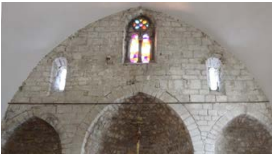
Figura 191. Tensor d'acèr en presbitèri de Sant Estèue de Betren [29]
