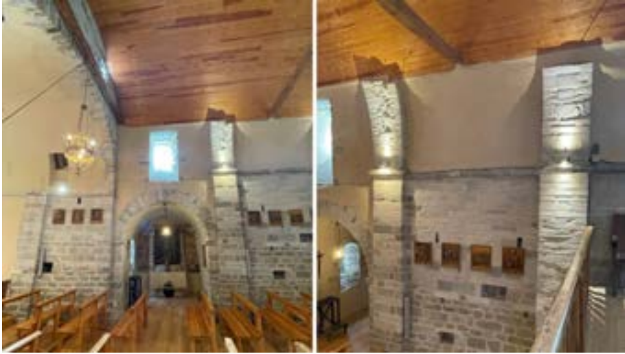
Figura 175. Linhas de collapse d'arcs e vòutes sus es impòstes de Sant Fèlix de Bagargue [40]
