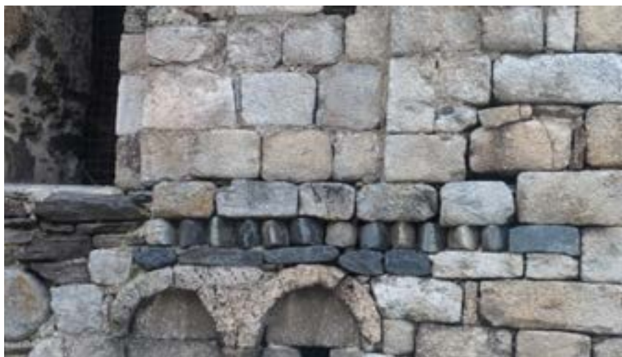
Figura 186. Detalh dera discontinuïtat dera decoracion dentada deth campanau d'Era Mair de Diu dera Purificacion de Bossòst [6]
