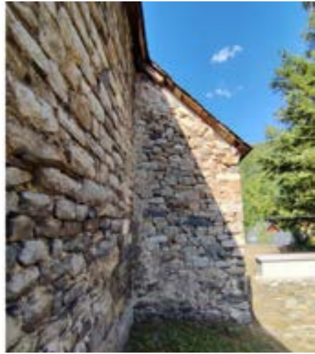
Figura 157. Detalh deth perfil des contrahòrts de reparacion estructurala dera façada septentrionala de Santa Eulària d'Unha [38]
