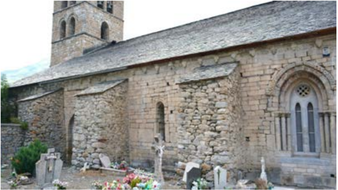
Figura 55. Contrahòrts d'estabilizacion dempús dera construccion inicial de Santa Maria d'Arties [34]
