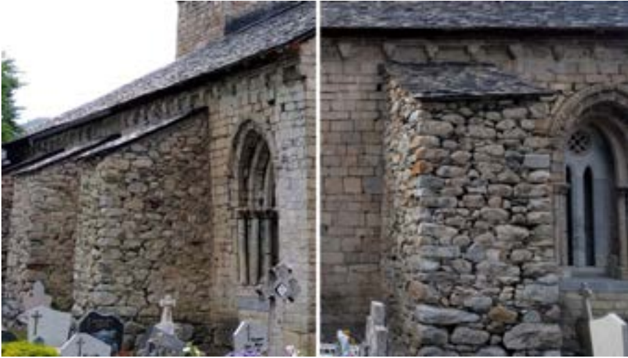
Figura 114. Resisténcia damb contrahòrts damb talús ena façada Sud de Santa Maria d'Arties [34]
