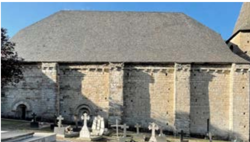
Figura 118. Contrahòrts dera façada de tramontana de Santa Maria de Cap d'Aran de Tredòs [41]
