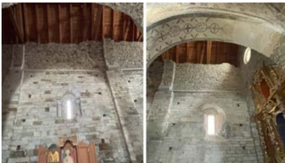
Figura 165. Detalh dera corbatura des vòutes de quart de canon de Santa Maria de Cap d'Aran de Tredòs [41]
