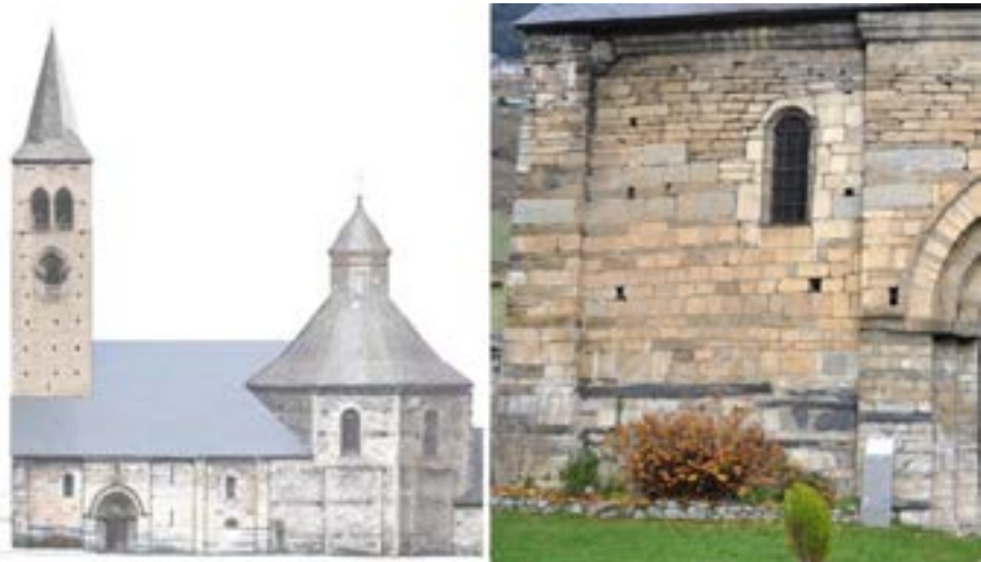
Figura 148. Contrahòrts dera façada meridionau de Sant Fèlix de Vilac [24] qu'entoren eth portau
