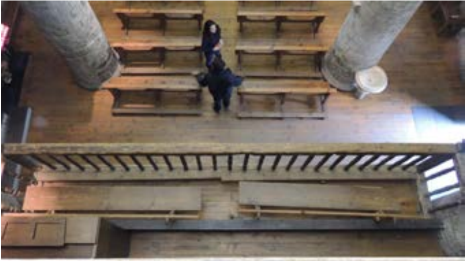
Figura 196. Viga d'acèr en còr d'Era Mair de Diu dera Purificacion de Bossòst [6]
