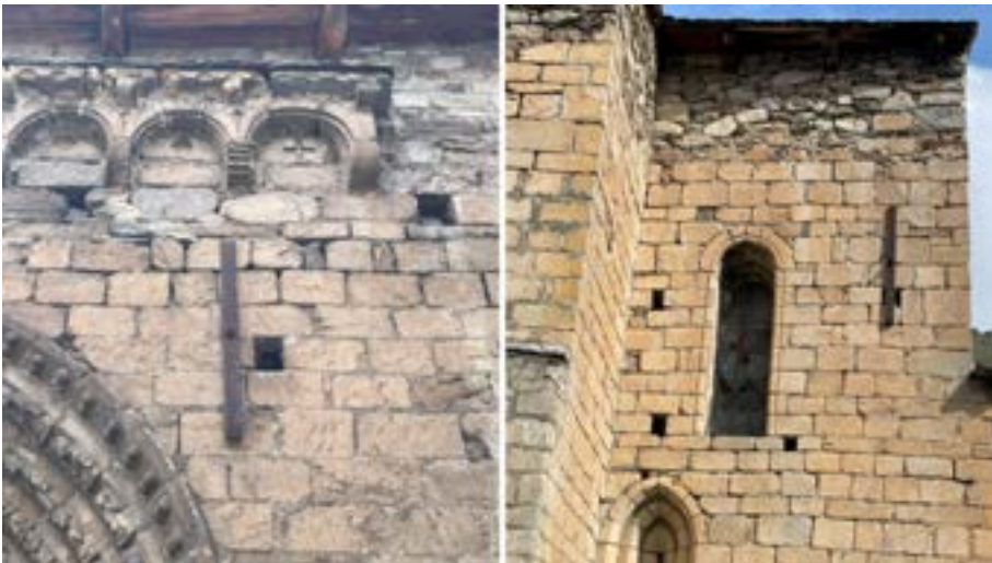
Figura 193. Anclatges metallics des tensors enes façades septenetrionau e meridiana de Sant Estève de Betren [29]
