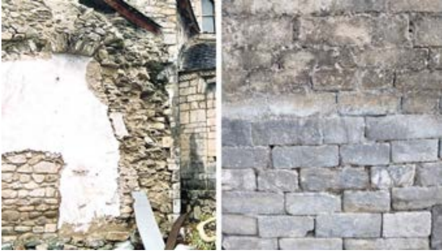
Figura 54. Murs de dobla huelha damb remplit de Santa Maria d'Arties [34]
