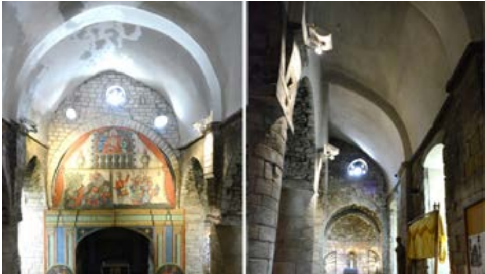
Figura 99. Vòutes funicularas en Era Mair de Diu dera Purificacion de Bossòst [6]
