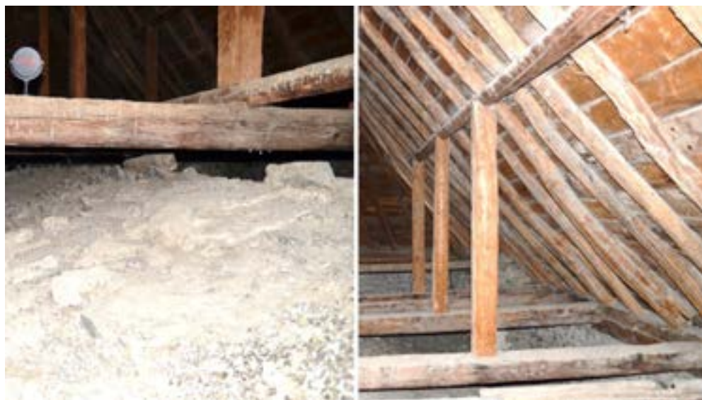
Figura 103. Vòuta e armadura dera cubèrta de Sant Martin de Tours de Gausac [26]
