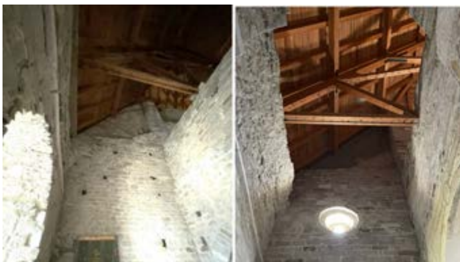
Figura 166. Traces des vòutes de quart de canon enes naus lateraus de Santa Maria de Cap d'Aran de Tredòs [41]
