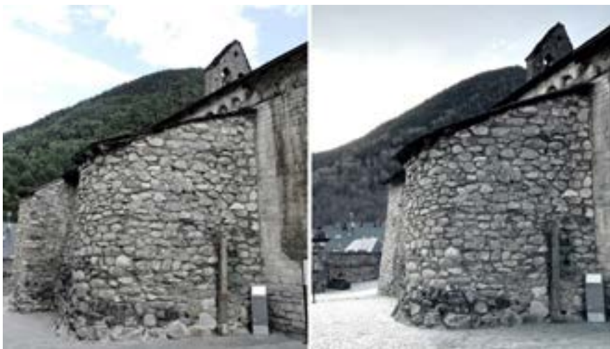
Figura 508. Reforma des contrahòrts dera façada septentrionau de Santa Maria d'Arties [34]
