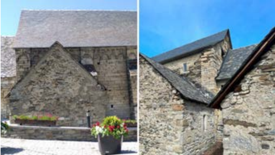
Figura 173. Capèles lateraus annexionades a Sant Fèlix de Bagergue [40] utilizades coma supòrts des murs de barratge
