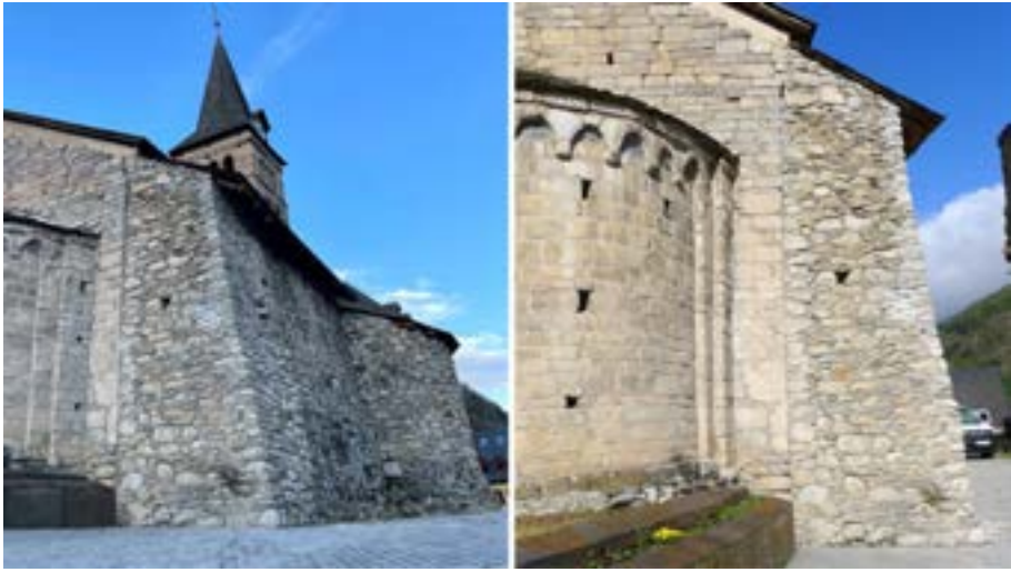
Figura 112. Grani esbauçaments en inici deth mur dera nau de Santa Maria d'Arties [34]
